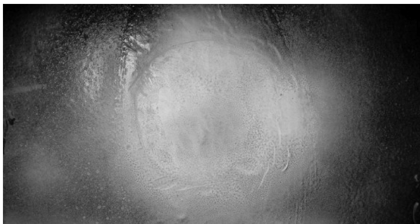
图 2-4 对渗漏测压管入口进行封堵后
